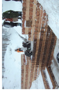
写真-2 木製治山ダムの施工 (秋田県鹿角市)
